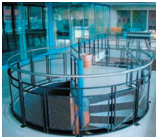
Die durchlaufenden Horizontaltraversen eigneten sich auch gut für gebogene Elemente.
